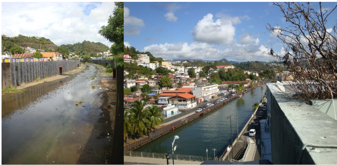
Lit dénaturé et pollué du canal Levassor en aval de la rivière Madame
