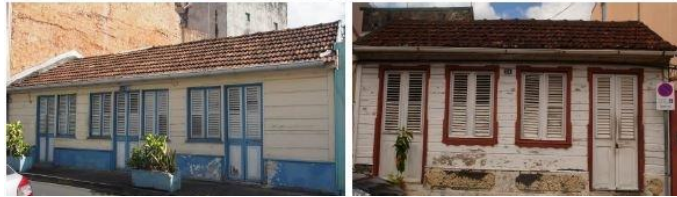
La maison urbaine à rez-de-chaussée
